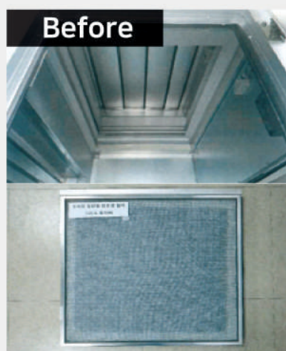
정전형 전도성 미세먼지 필터 작동 전 외관(오염되지 않음)
